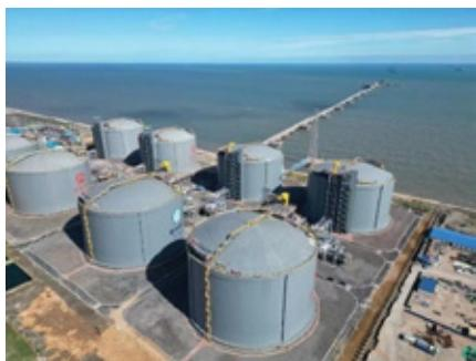
9月21日，海油工程总承包的唐山LNG接收站二阶段工程提前21天完工投产。该项目是环渤海地区最大LNG接收站，规划建设**20座20万立方米储罐**，对优化京津冀能源结构意义重大。公司发挥EPC全产业链优势，联合研发中心建立联动循环机制，推动项目加速。项目团队创新技术工艺，借助“Checklist”清单保障安全施工，多项自动化技术提升建造水平。
